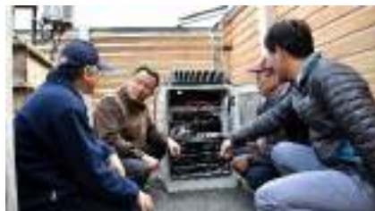
▲視察南橫公路通訊設備(2018.03.06)
