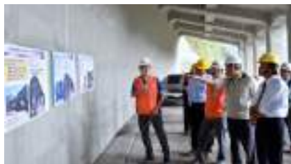
▲視察南橫公路109k梅山明隧道工程進度(2018.03.05)
